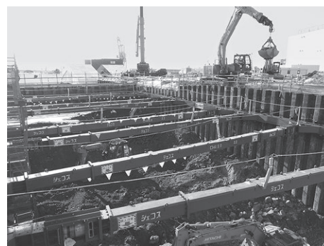
建設工事中の防潮堤
